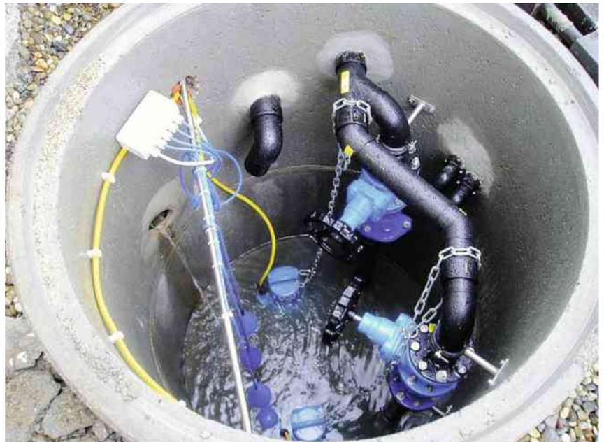
Deux pompes submersibles en action. Même la chambre en béton a été livrée par Häny AG.
