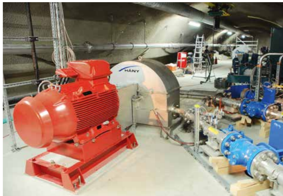
Zur mechanisch schadlosen Energieumwandlung des Wassers wird eine Pelton-turbine eingesetzt. Diese wandelt zusammen mit dem angeschlossenen Generator die Energie in Strom um, der für den Betrieb des GBT verwendet werden kann.
