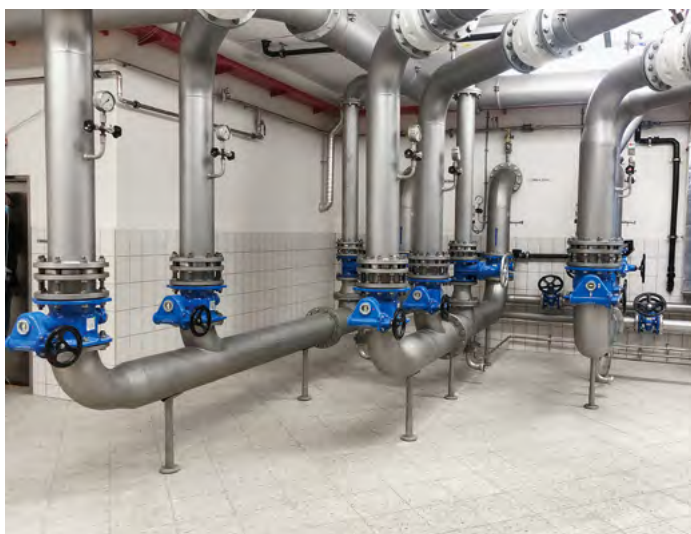
Das Innenleben eines Grundwasserpumpwerks: ein Zusammenspiel aus Pumpen und Armaturen. Die Absperrrklappen, Rückflusssperren und Schieber stammen von Erhard/Hagenbucher.
