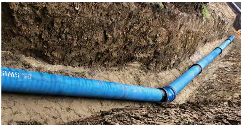
Leitungsbau zum Nachbarwerk: Auch hier wurden die bewährten FZM-Gussrohre mit BLS-Verbindung eingesetzt.
