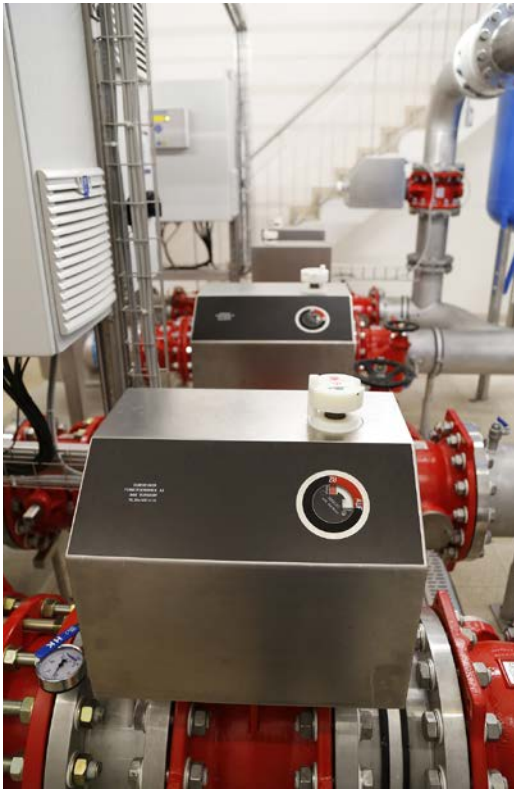
Fig. 3 Klappensteuerung und -antrieb zur Verhinderung möglicher Druckschläge. Eine Entwicklung von SCHEIDEGGER.
