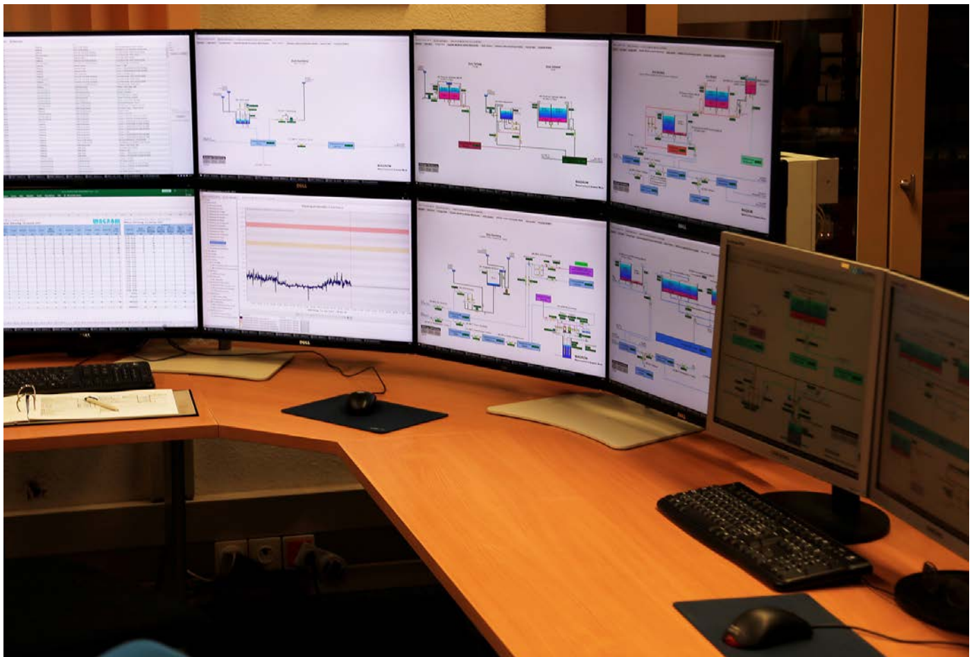
Fig. 1 Leitzentrale des Wagrom in Ins: Die Visualisierung bildet die tatsächliche Geografie ab und liefert sämtliche Angaben von Übersichtstabellen des Gesamtsystems bis zu Detailwerten einzelner Anlageteile.
