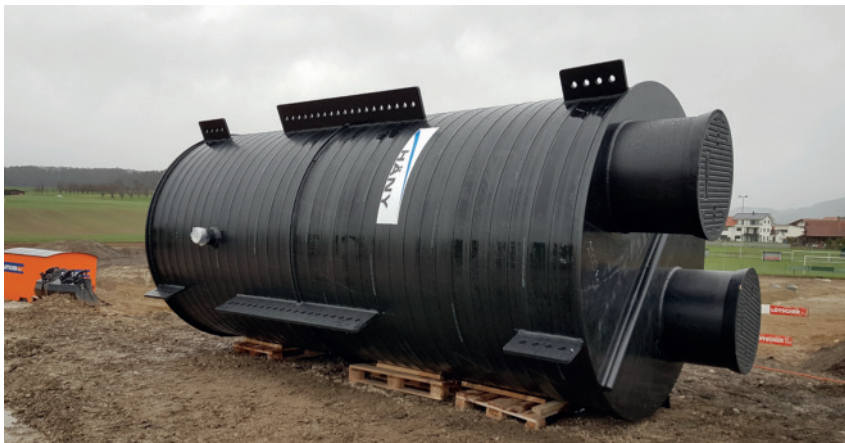
Der neue Schmutzwasser-Pumpenschacht für die Anlage Seebli
