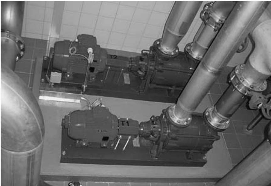
Bild 2: Rückwärtslaufende Standardkreiselpumpe (PAT)
