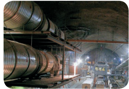
Schachtfuss (Tiefe 800 m) Bottom of shaft (depth 800 m)
