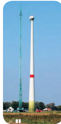
Turm vor Montage Tower before monting
