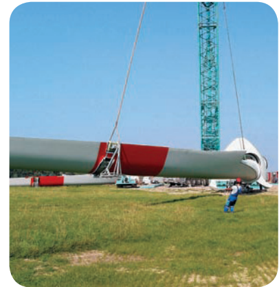
Montage eines Rotorflügels (L = 35 m) Assembly of a rotor blade (L = 35 m)
