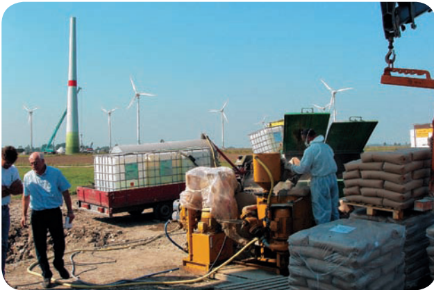
Häny Anlage beim Verpressen Häny in operation
