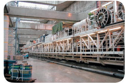
Aufbau der TBM in Startschacht Assembly of TBM at the Stratford box
